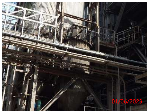
รูปที่ 2-9 ไซโลเก็บผงหินปูนแบบปิด
