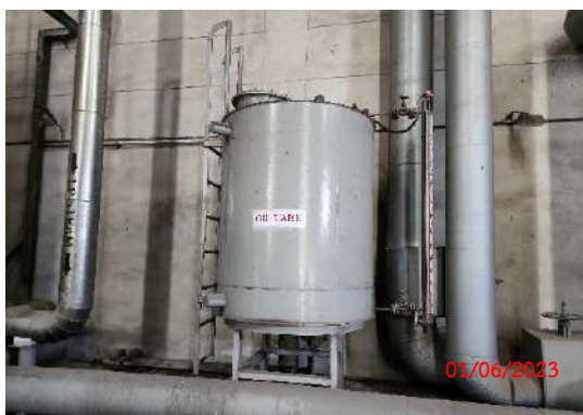
รูปที่ 2-65 Emergency Gravity Oil Tank
