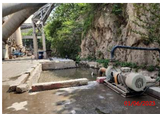
รูปที่ 2-68 บ่อน้ำขนาด 60 ลูกบาศก์เมตร ได้หม้อผลิตไอน้ำ
