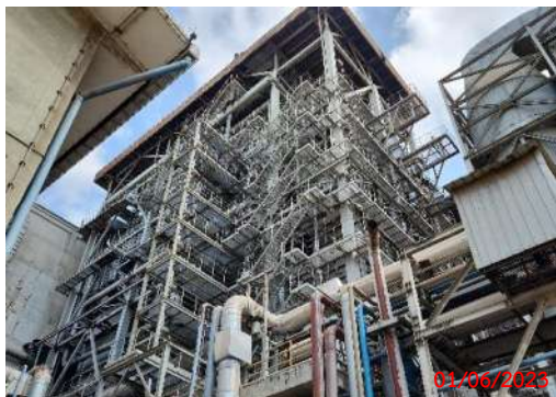
รูปที่ 2-52 อาคาร CFBC Boiler ที่มีทางเดินและบันได พร้อมราวกันตก
