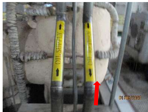
รูปที่ 2-64 ระบบท่อน้ำมันเลี้ยงแบร์ริง ของ Turbine&Generator
