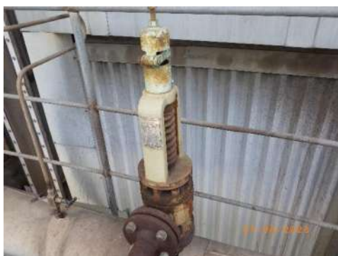
รูปที่ 2-54 Safety Valve ของหม้อไอน้ำ
