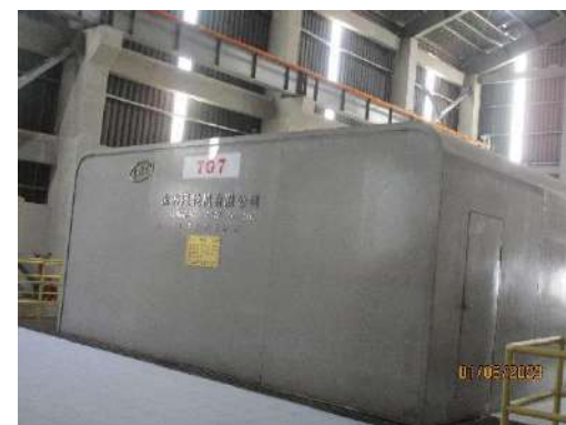
รูปที่ 2-21 เครื่องผลิตกระแสไฟฟ้าในอาคารปิด
