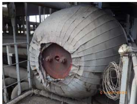
รูปที่ 2-53 Steam Drum ของหม้อไอน้ำ
