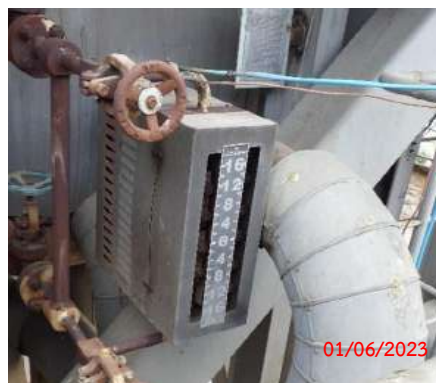
รูปที่ 2-61 เครื่องวัดระดับน้ำของหม้อไอน้ำ
