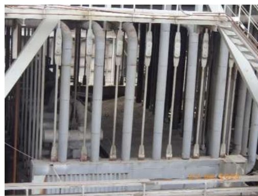
รูปที่ 2-57 Rapid Drain Piping System ของหม้อไอน้ำ
