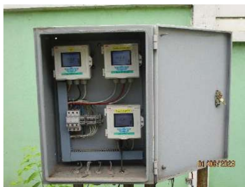
รูปที่ 2-44 ระบบตรวจคุณภาพน้ำอัตโนมัติ
