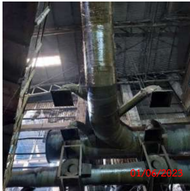
รูปที่ 2-17 พัดลมดูดอากาศ ห้องรับขยะของโรงผลิต RDF
